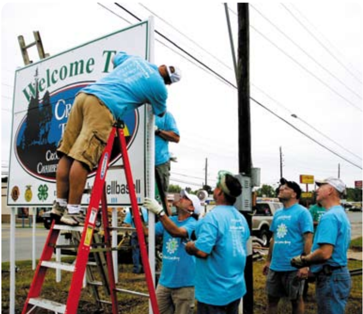
Employees construct a new “Welcome to Crosby” sign located at the entrance of the town on F.M. Road 2100. The project was one of three in Crosby as part of the company’s Global Care Day. Los empleados construyen un nuevo anuncio de Bienvenida situado a la entrada de la ciudad de Crosby sobre la calle F.M. 2100. El proyecto fue uno de tres llevados a cabo en Crosby como parte del Día del Cuidado Mundial.
